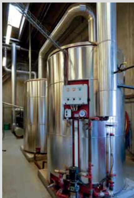
Isolering af tanke.
